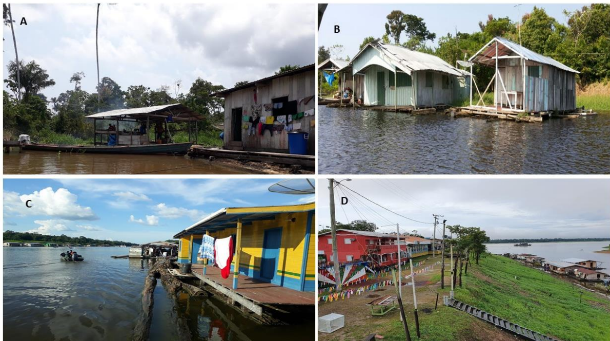
Figura 2: Propriedades estruturais peculiares das moradias ribeirinhas. A) Tronco de árvore flutuante usada para sustentar a casa sobre água, com presença de casa de farinha ao lado. B) Casas flutuantes precárias próximas as margens do rio. C) Comunidade formada por 50 casas
